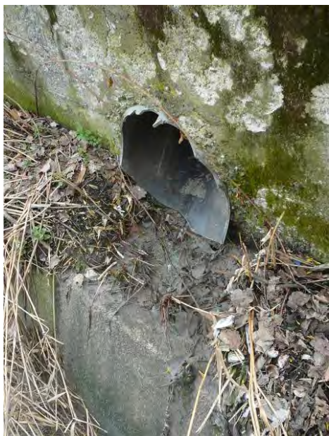
Figura 2.10 – Foto a sx: stazione di campionamento n° 6. Tubatura di scolo di reflui fognari nel tratto con alveo artificiale in cemento. Foto a dx: Tubatura di scolo di reflui fognari più a valle con alveo di scavo non in cemento
